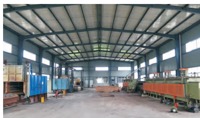
热处理车间 Heat Treatment Workshop
