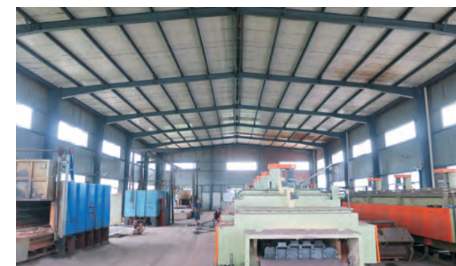
热处理车间 Heat Treatment Workshop
